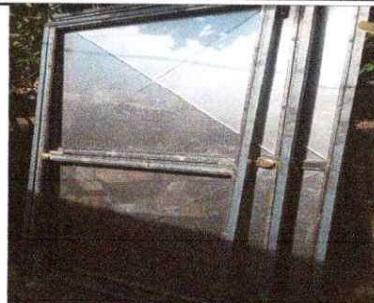
FOTO 8: FABRICACION E INSTALACION DE PUERTAS DE METAL EN MODULO
