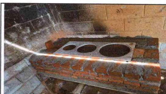
FOTO 4: SUSTITUCION DE ESTUFA RURAL (COMPLETA) INCLUYE PLANCHA Y CHIMENEA
