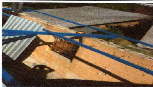
FOTO 7: SUSTITUCION DE LAMINA, POR LAMINA TROQUELADA CALIBRE 26
