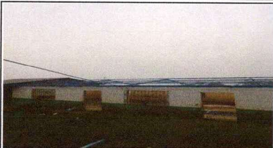
FOTO 1: SUSTITUCION DE LAMINA, POR LAMINA TROQUELADA CALIBRE 26
