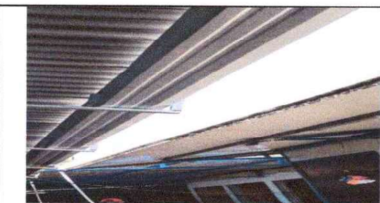
FOTO 5: SUSTITUCION DE CANAL DE METAL
