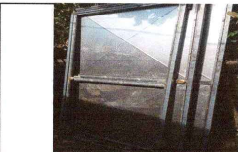
FOTO 3: FABRICACION E INSTALACION DE PUERTAS DE METAL EN MODULOS
