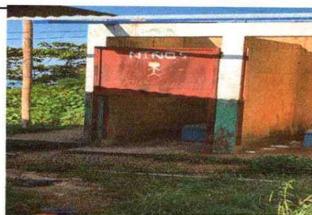
FOTO 10: MANTENIMIENTO EN PUERTA DE SANITARIO
